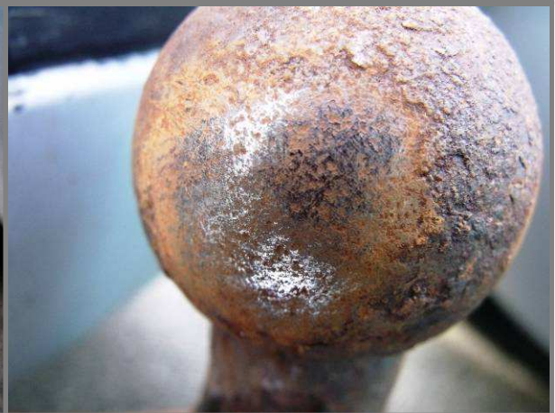
Obr. D10 – detail očištěné struktury
